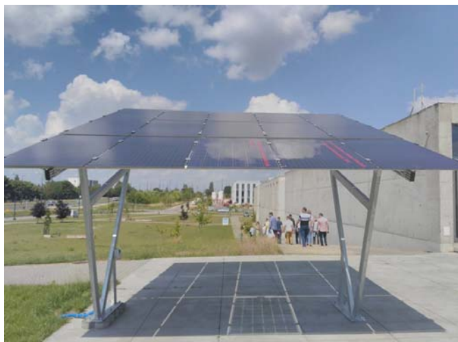
Rys. 3. Panele zamontowane na konstrukcji nośnej
